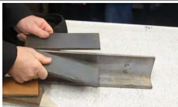
Деление плитки посредством металлического уголка
