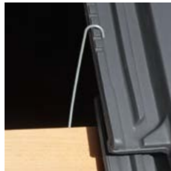
Die Fixierungskerben für die Sturmklammern.
